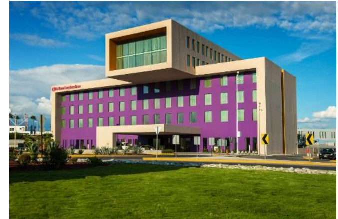
Hilton Garden Inn Monterrey Aeropuerto
