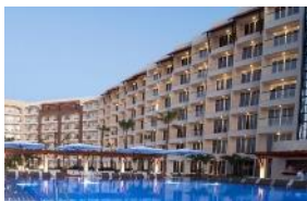
Krystal Grand Los Cabos Abrió 2T17 454 Habitaciones Propio @ 50%
