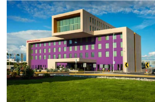
Hilton Garden Inn Monterrey Aeropuerto
